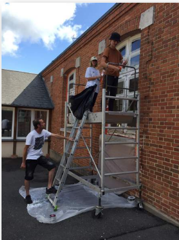
Rénovation des fenêtres de l'école par Lilou et Kylian
