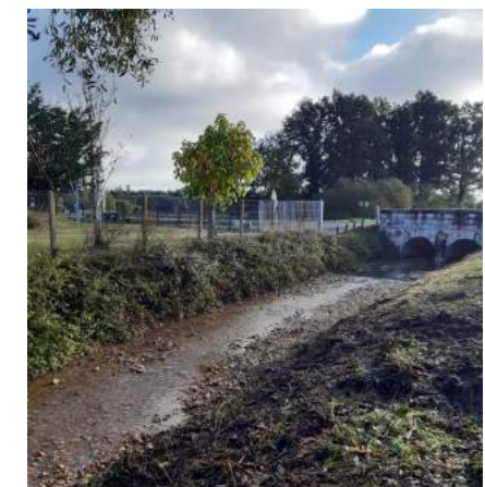
Travaux seuil du pont de Bonnée
