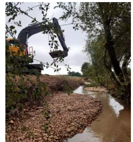
Travaux sur la Bonnée
